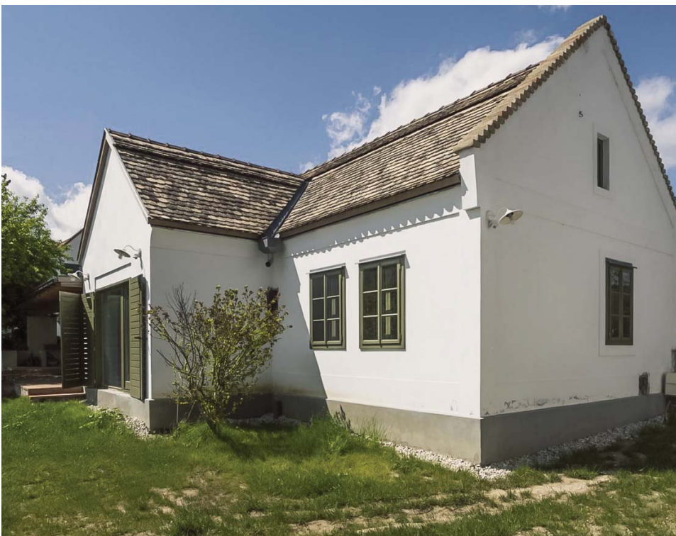
» Népi építészeti stílusjegyekkel rendelkező modern lakóház (Dénes György, Balatonhenye, femina.hu)
